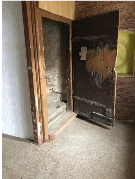
Escaleras del ala oeste que suben hacia ático.
